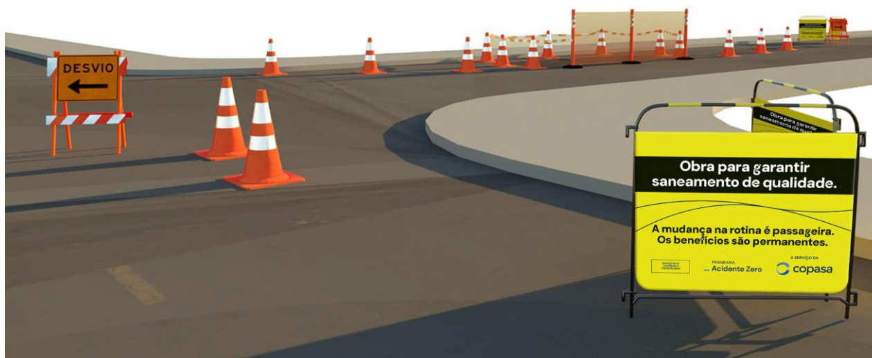
Figura 4 - Sinalização em pista de sentido duplo (próximo a cruzamento) 5.1.3 f
