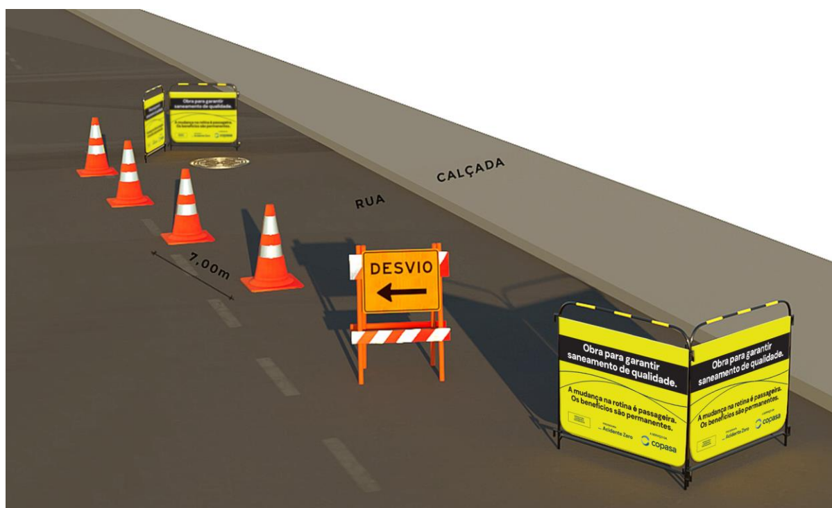
Figura 1 - Sinalização em pista de sentido único
